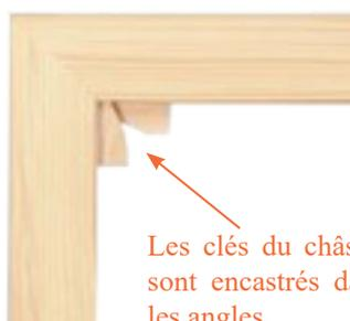
Les clés du châssis sont encastrés dans les angles.
